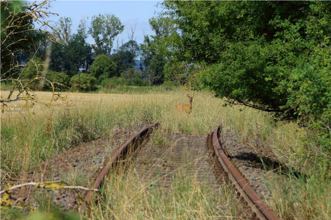
Abschnitt Stumsdorf – Zörbig: Stillgelegt
